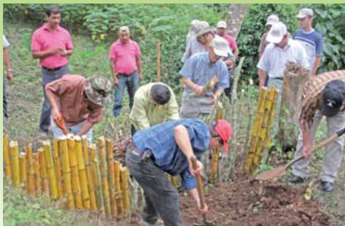
Foto JICA-INTA: Dique de contención.
