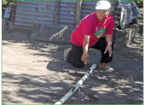
Figura 17: Lavado de la tubería de distribución principal.
