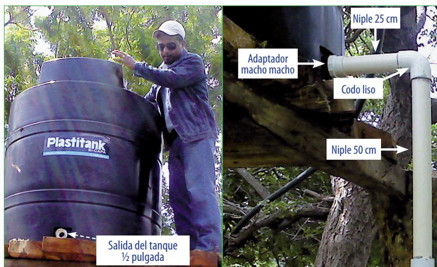
Figura 5: Instalación del adaptador macho, niples y codo.
