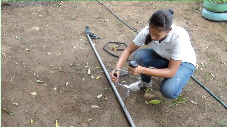
Figura 13: Perforación de tubería principal de distribución.
