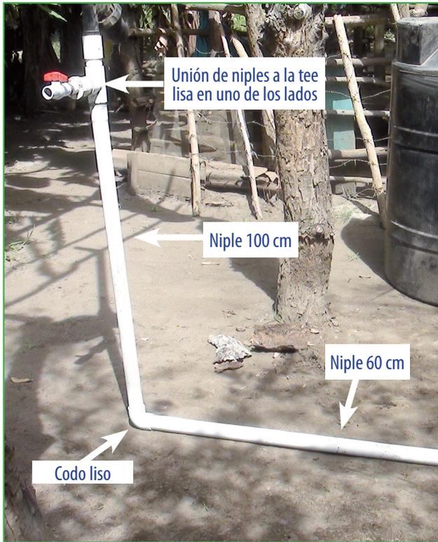
Figura 9: Instalación de niples y codo.
