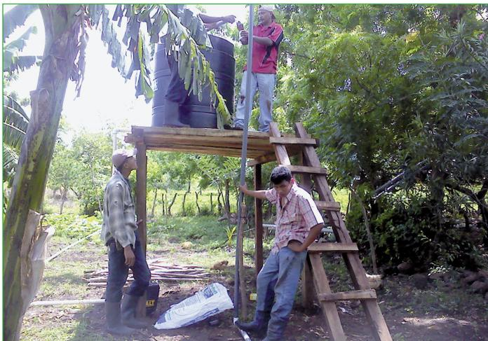
Figura 4: Conducción del agua hacia el tanque de almacenamiento.
