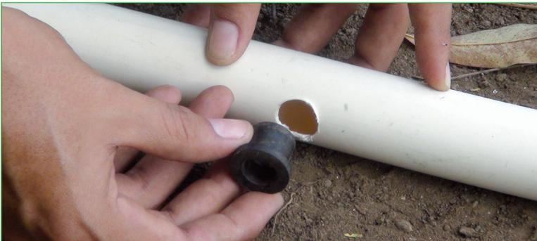
Figura 15: Instalación del empaque en la tubería de distribución principal del sistema de riego.
