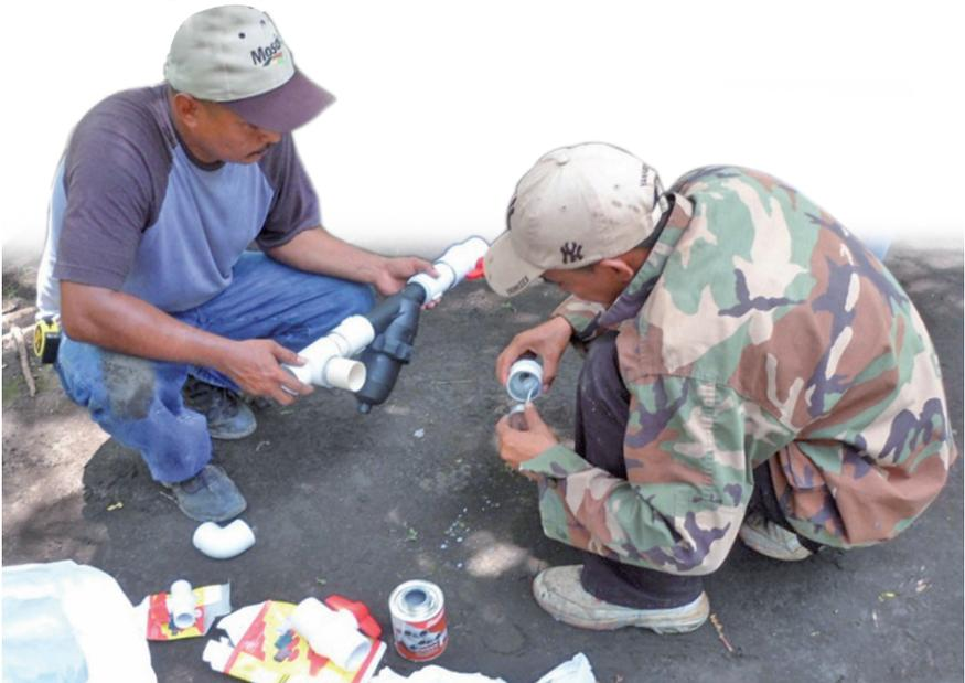
Figura 6: Conexión de válvula, adaptadores hembra, filtro y niples.
