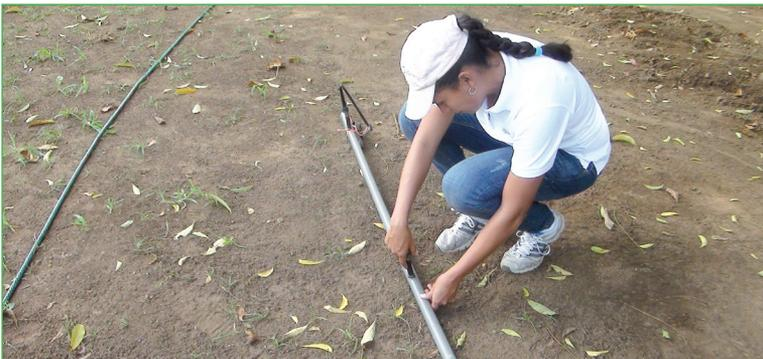
Figura 16: Instalación del conector con la ayuda de un pedazo de palo.
